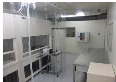
クリーンルーム内 (前処理室)
