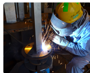
ガスシールドアーク溶接
