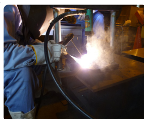
被覆アーク溶接
