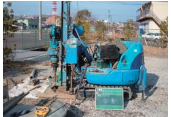
写真 土壤採取ボーリング機械
