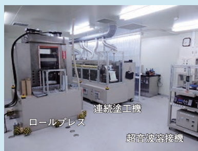
図2 ドライルーム室内
