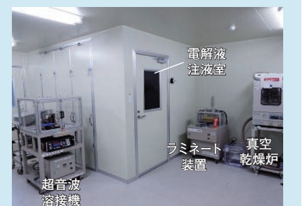
図3 電解液注液室(ドライルーム内)
