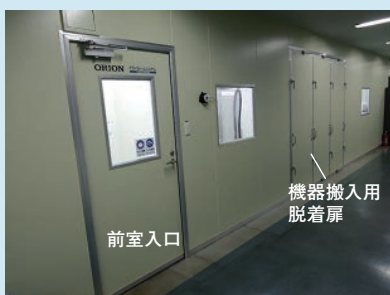
図1 ドライルーム外観
