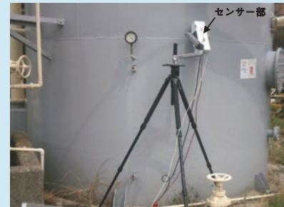
写真1 プラント設備溶接部の残留応力測定の様子
