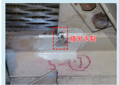
写真1 クレーン内部の疲労き裂
