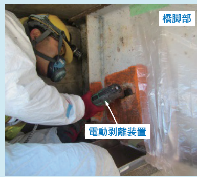
写真1 分析に用いる試料(橋梁塗膜)の採取状況
