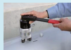
接着強度の現地測定
