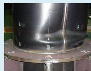
図2 鋼管杭座屈状況
